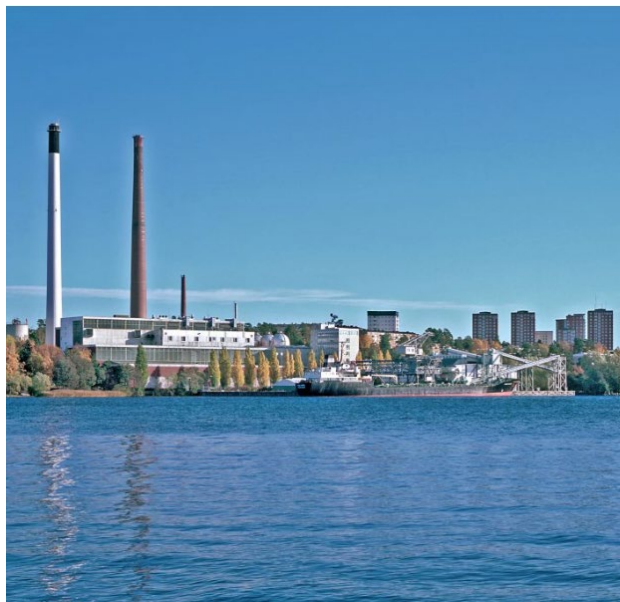
Hässelbyverket i Stockholm. Foto: stockholmexergi.se
